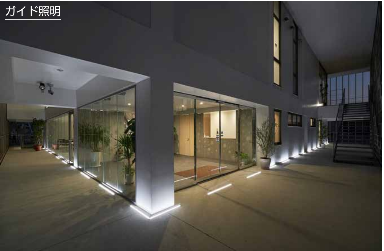
株式会社技建本社ビル 所在地：沖縄県 設計：一級建築士事務所 細矢仁建築設計事務所 照明設計：有限会社EOSplus 高橋翔・福島颯太 施工：株式会社大興建設 写真：細矢仁
