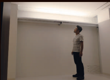
天井折り上げ・折り下げ照明
