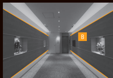
B ルーチ・パワーフレックス 特注品 20mm ピッチ 型番 LFP20-T**・L27-CL-I 電球色 2700K 563 lm/m
