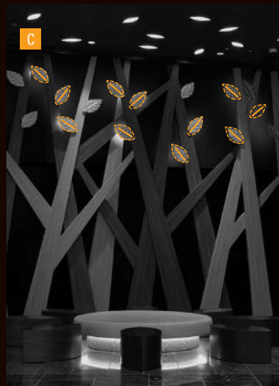
C ルーチ・パワーフレックス 100V CF 型番 LFPCF25-0232-100-L30-CL-I 電球色 3000K 528 lm/m
